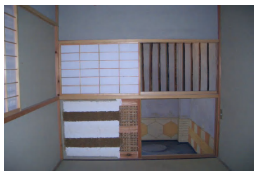
茶室・竹小下地 土壁上まで 工程が展示しています。
