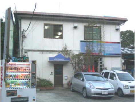
湯河原町鍛冶屋にある事務所兼作業場
